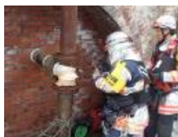
坑口のガス測定 小樽市消防本部
