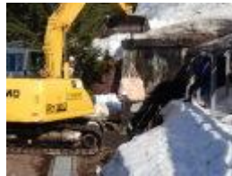
坑道入口の土嚢積み 三建工業
